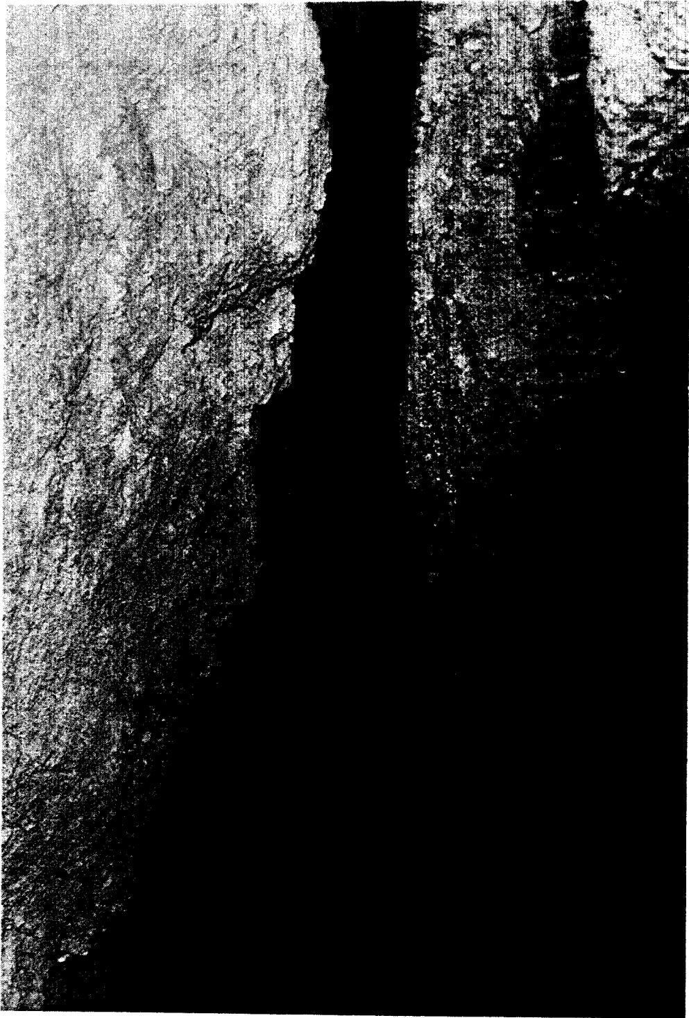
Abb. 9: Ausgeronnene mylonitisierte Dolomite bei Station 3.297 m (Valkastielstollen). Bildbreite rund 4 m.
